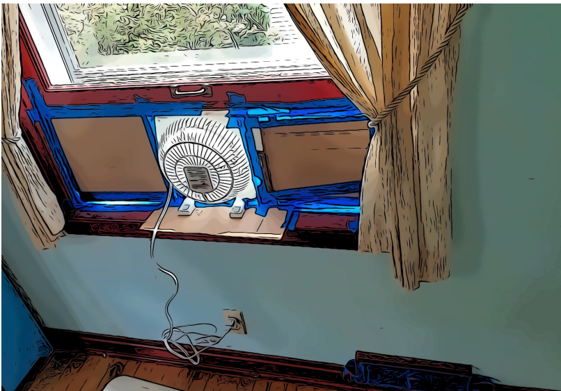
Foto 5. Ventilador montado en la ventana para soplar el aire del exterior dentro la habitación, con la ventana sellada, excepto donde se encuentra el ventilador.
