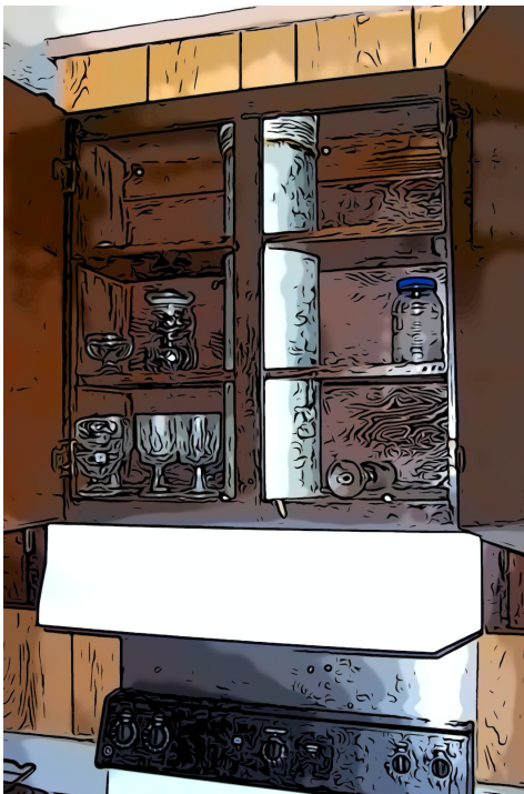
Foto 5. Campana extractora de cocina, que muestra el conducto hacia el exterior. Las campanas extractoras sin conducto no aumentan la ventilación.
